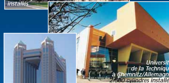
Hôpital «La Charité» à Berlin/Allemagne 13.000 cylindres installés
