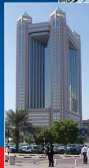
Hôtel Fairmont à Dubai/UAE 2.500 cylindres installés
